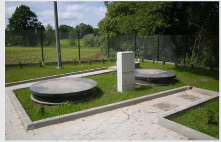
▶ Installation avec bassin de décantation et réservoir tampon déportés pour s'adapter à un espace restreint.
